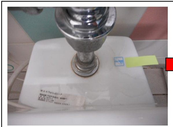
男子トイレ 大便器の水垢等による汚れ
