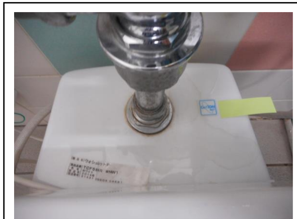
男子トイレ 給水管接続部周辺の水垢
